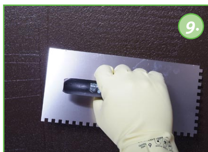
9. Nakładanie drugiej warstwy KÖSTER Bikuthan 2K
